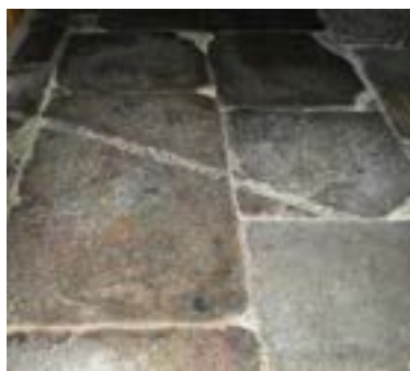
Obr. C-118 Žulové desky se známkami po opotřebení
