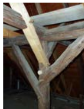
Obr. B-178 Středový sloup s četnými chybějícími prvky a Obr. B-179 Opravený styčník po doplnění
