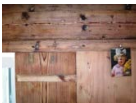
Obr. C-110 Odkryté neošetřené plochy roubené stěny a posuvných okenic
