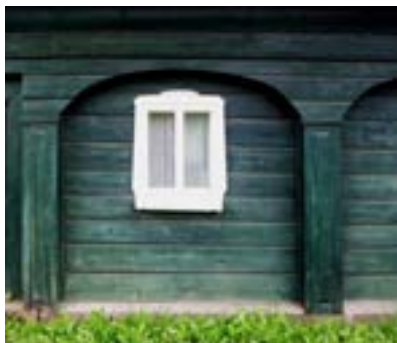
Obr. C-73 Dřevěný obklad sloupků, pásků, rozpěry a ližiny podstávky (Vlčí hora)
