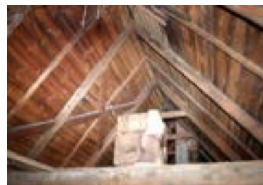
Obr. B-175 Náčrt krovu s ležatou stolicí, obec Cunewalde / Obr. B-176 Latě vložené mezi krokve podírají podkladové bednění pro břidlicovou krytinu (Foto: St. Freitag)
