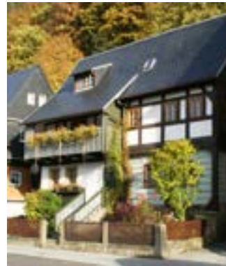
Obr. B-126 Uzavřená pavlač nad vstupním dílem domu (Meschwitz) / Obr. B-127 a obr. B-128 Otevřená pavlač nad vstupem a zděnou částí domu (Postelwitz, nákres: H. Lommatzsch)
