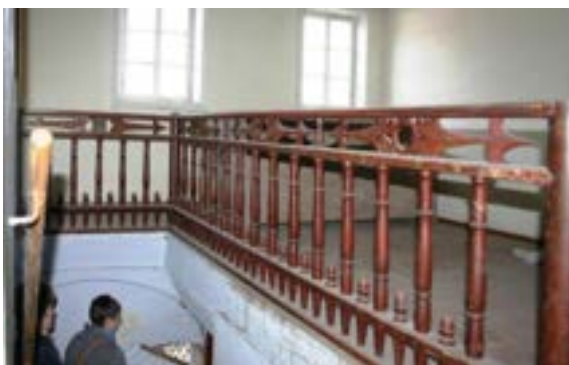
Obr. C-164 Jako zábradlí sloužily nejprve jednoduché dřevěné tyče. Ztvárnění tyčí zábradlí a lemování schodišťových zrcadel se později stalo řemeslnickým klenotem.
