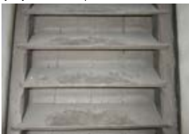
Obr. C-161 Nasunuté stupnice
