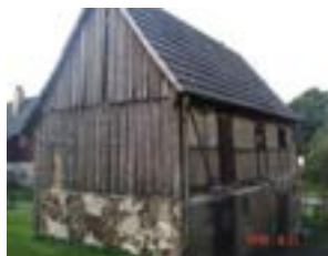
Obr. E-9 Hospodářská stavba se zděným přízemím a hrázdným patrem, obec Großhänchen, (Foto: Marticke)
