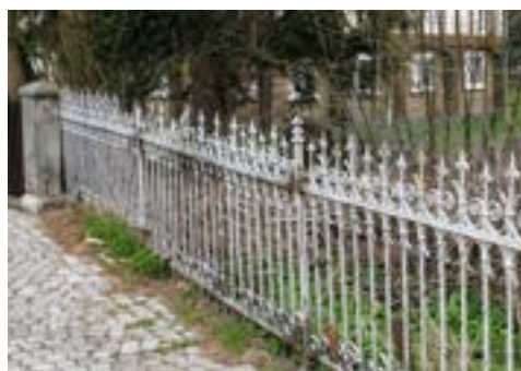
Obr. E-36 Železný plot v obci Großschönau
