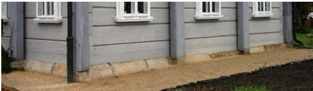
Obr. B-22 Vyčištěná podezdívka z pískovce ve zřídka viděné formě: Podezdívka leží sice v úseku podstávkových polí zalícované ke světnici, pak je ale nakloněna směrem ven; ochrana patek sloupů proti vystupující vlhkosti s kusy dubových prken. (Obětované dřevo, trvanlivé asi 25 let), (Großschönau)
