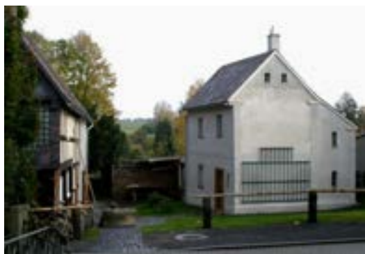
Obr. E-19 Paralelní dvůr s úsporným dlážděním, obec Berthelsdorf
