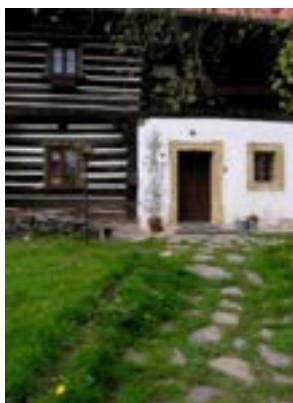
Obr. E-14 Trávník zpevněný nepravidelnými přírodními kameny, Starý Týn (Foto: J. Cieslak, upraveno)
