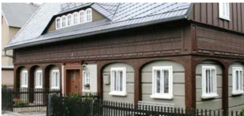
Obr. C-77 Obklad podkrovního polopatra s iluzivní pásovou bosáží a diamantováním (Großschönau)
