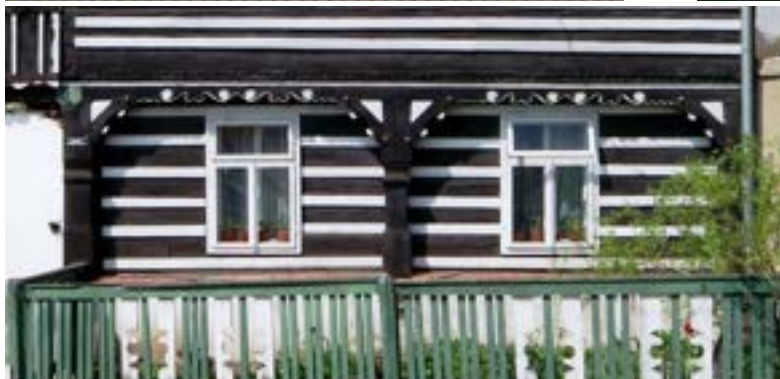
Obr. B-67 (nahore vlevo): Neprofilované sloupy, překlátované rovné pásky, rovná spodní ližina s malým vybráním (Sebnitz)
