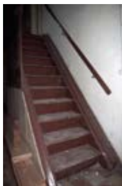
Obr. C-164 Jako zábradlí sloužily nejprve jednoduché dřevěné tyče. Ztvárnění tyčí zábradlí a lemování schodišťových zrcadel se později stalo řemeslnickým klenotem.
