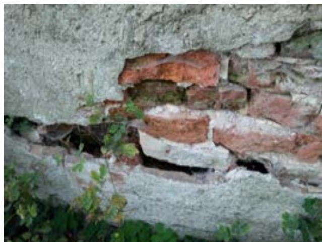
Obr. B-36 Zdivo ze zvonivek u síně / (Neugersdorf / Foto: J. Gosteli, výřez) / Obr. B-37 Použití zvonivek ve vstupní části a jako podstávková podezdívka (Rumburk)
