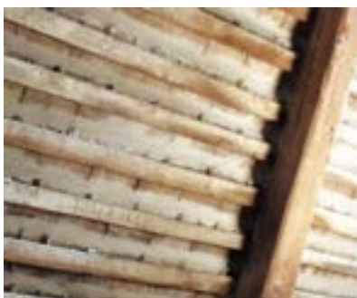
Obr. C-14 Vlevo: Staré bobrovky nově položené na maltové podloží / vpravo: maltové podmazání příčných spár
