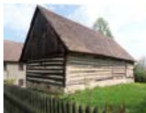
Obr. E-10 Roubená hospodářská stavba s prodloužením v hrázdnou konstrukci, mezery mezi trámy vyplněny hliněnou mazaninou, Lhota
