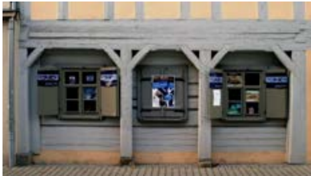
Obr. B-66 (vpravo) Pásek doplněný prkenným krytem (Soběnice) / nůžková vzpěra z překřížených pásků u podstávkové konstrukce s dlouhými (průběžnými) sloupy (Sulikow, PL)
