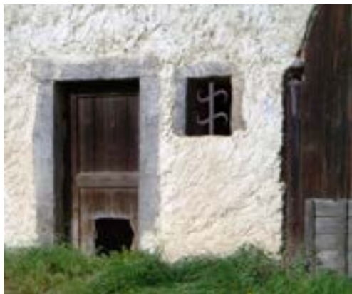
Obr. C-124 Vybavení stáje – dveře, okenní mříž a vrata v Cunewalde
