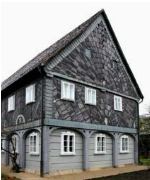
Obr. C-92 Obnovené břidlicové obklady v Großschönau (vlevo) a Lipové (vpravo)
