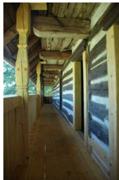
Obr. B-132 (skupina) Průhled pavlačí po obnově: první sloupek vpravo je nastaven plátem; vrchní zdobená část zůstala zachována. (Foto J. Pešta)
