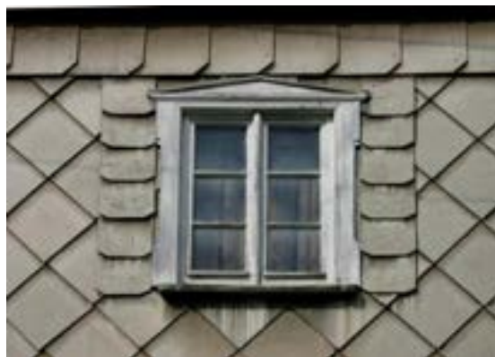
Obr. C-87 Vlevo: Eternitový obklad z maloformátových šablon červeného odstínu (Vlčí hora)/ Vpravo: Obklad z maloformátových šablon
