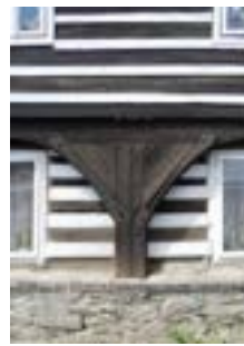
Obr. B-65 (nahore) Pásek spojený rybinovým plátem / začepovaný pásek / začepovaný rohový klínek – záporka (náčres z „Palm, Bernert, Rentsch, Rdzawska, & Pinkau. (2010). Dokumentation über Umgebendehäuser / Dokumentation o podstávkových domech/ . (P. Palm, Hrsg.)
