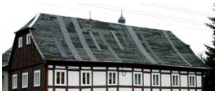
Obr. C-24 „Zalátané“ trhliny v krytině bitumenového šindele
