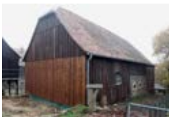
Obr. E-8 Dřevěná stodola s vestavěnou koňskou stájí z masivního zdiva, obec Ebersbach
