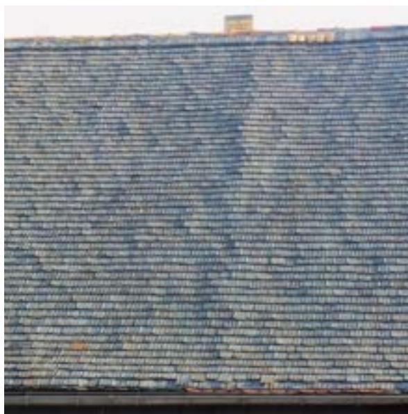
Obr. C-9 Živá plocha střechy s modročernými glazovanými ručně vyráběnými bobrovkami (Weifa)
