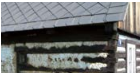
Obr. C-26 Nové vláknocementové krytiny v barvě břidlice: vlevo a uprostřed z šablon, vpravo zvlněné tašky (netradiční a nevhodný formát a tvar)
