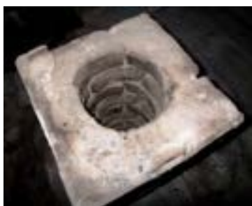
Obr. D-8 a Obr. D-9 „Ruský komín“
