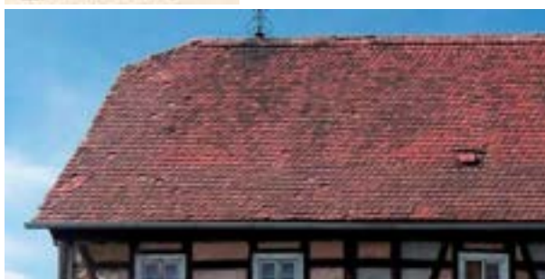
Obr. C-10 Šupinové krytí Radzimów (PL) / korunové krytí Schöna (D)
