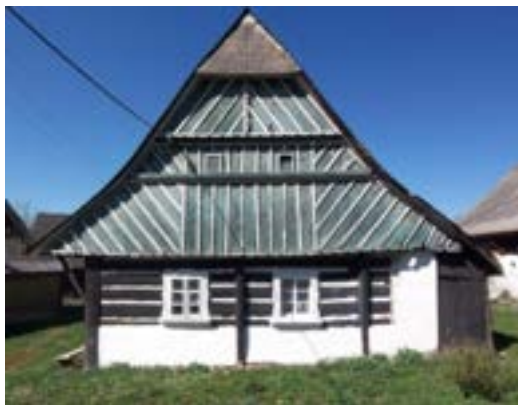
Obr. A-2 Stěnové kleštiny, obec Hrubá Horka
