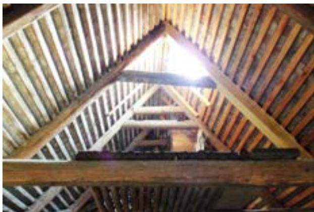
Obr. C-48 Střešní výlezové okno pro kominika (ca. 40/50 cm) osvětluje tuto půdu, která nemá být zastavěna
