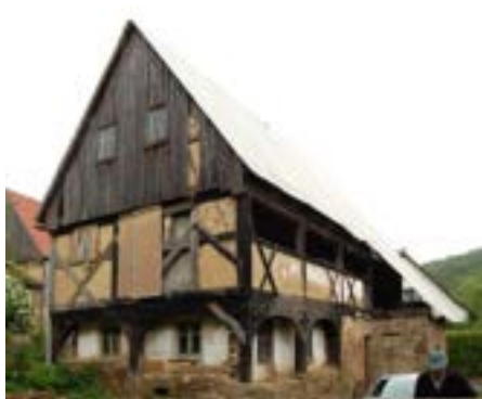
Obr. B-123 Pavlač, zapuštěná do hmoty domu (Döhlen, Foto: U. Rosner, zprac.) / Obr. B-124 Vystupující pavlač (Kleinkunitz) / Obr. B-125 Vnitřní pohled do pavlače (Kleinkunitz)
