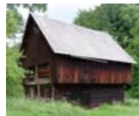
Obr. E-11 Dřevěná stodůlka s roubeným přízemím, Dlouhý Důl
