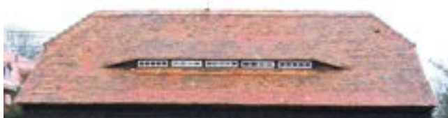
Obr. C-36 „Štika“ v taškové střeše (Ebersbach), nároží vikýře jsou vykryta taškami
