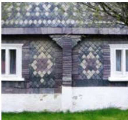
Obr. C-87 Vlevo: Eternitový obklad z maloformátových šablon červeného odstínu (Vlčí hora)/ Vpravo: Obklad z maloformátových šablon
