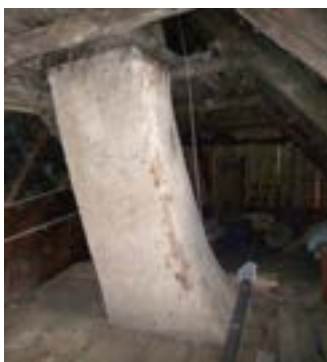
Obr. D-4 a Obr. D-5 Omítnutý dymník v horním patře a v podkroví, Ličenice, 2008
