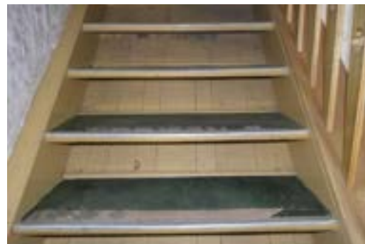
Obr. C-168 Nevýhodná změna prvního nebo posledního schodu způsobená změnou podlahou / Omyvatelný povrch schodů
