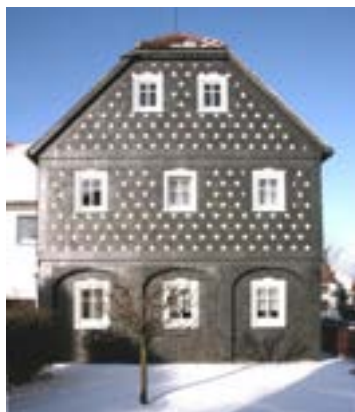
Obr. C-87 Vlevo: Eternitový obklad z maloformátových šablon červeného odstínu (Vlčí hora)/ Vpravo: Obklad z maloformátových šablon
