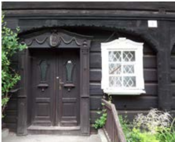
Obr.: Bohatě zdobené dřevěné zárubně v Dlouhém Dole
