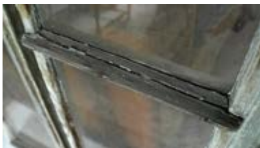
Obr. C-136 Zničená okapnice, prasklá příčka, silně zrezavělé kování s vadami
