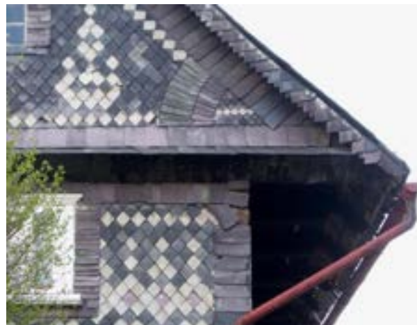
Obr. C-89 Vlevo: Kříž, srdce a kotva (Kryštofovo Údolí)/ Vpravo: Různobarevný obklad závětrné prkenné lišty a okapnice (Chotiněves)
