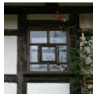
Obr. C-127 Okno s otočným křídlem v hrázděném patře
