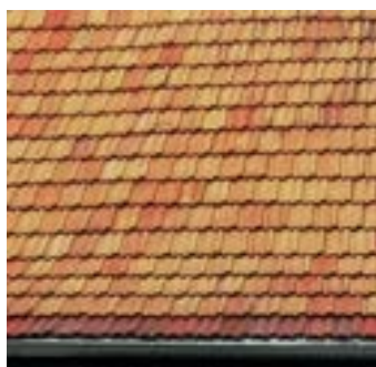
Obr. C-12 Malý rozměr bobrovek umožnil i zapracování takovýchto okrasných prvků.
