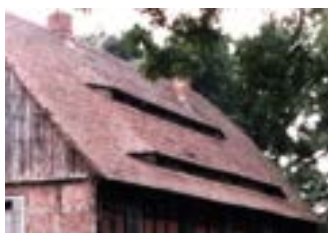
Obr. C-35 Větrací „pásky“ v úrovni podkroví, Lhota (Ústecký kraj), Wartha (Landkreis Bautzen) a Bukovec (okres Česká Lípa/Foto: J. Cieslak, upraveno)
