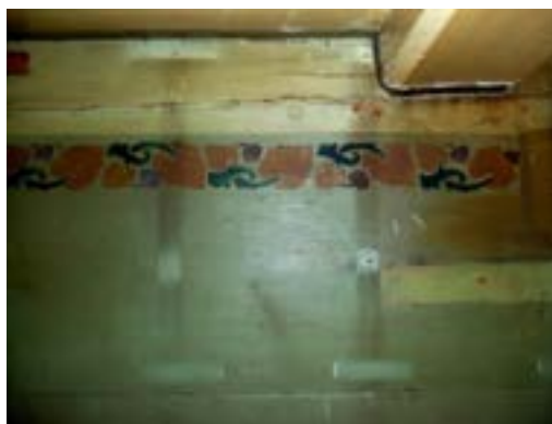
Obr. C-106 „Pivní lazura“: směs odstátého piva a pigmentu / Nátěr olejovou barvou s ozdobným lemem, znečištěný / Obložení dřevěnými kazetami v selském domě
