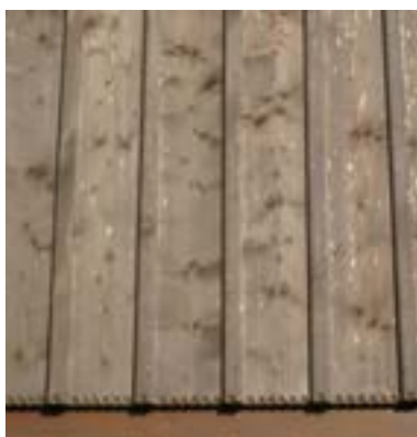
Obr. C-80 Smrkový obklad s lazurovým a olejovým nátěrem
