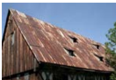
Obr. C-30 Zkorodovaná krytina z profilovaného plechu (s nastavěnými vikýři), Marczyce (PL, 2012).
