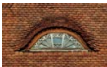
Obr. C-41 Další varianty „volského oka“ (název odvozen od polokruhových oken), v krytině z pálených tašek (Großschönau) / a v břidlicové krytině (Železný Brod)
