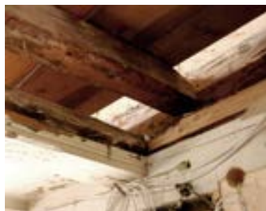
Obr. B-143: Uložení dvojitého stropu (situace hrubé stavby během hloubkových sanačních opatření)
