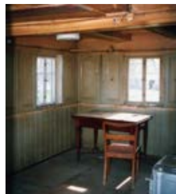
Obr. C-106 „Pivní lazura“: směs odstátého piva a pigmentu / Nátěr olejovou barvou s ozdobným lemem, znečištěný / Obložení dřevěnými kazetami v selském domě
