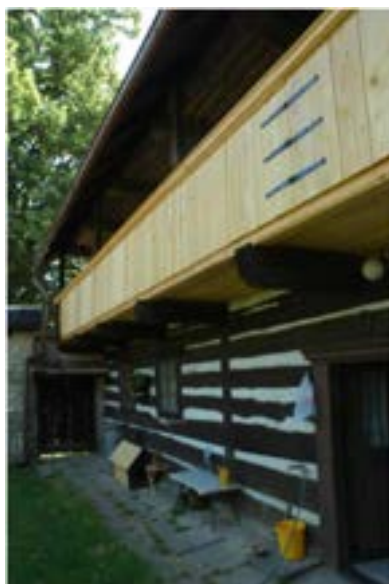
Obr. B-132 (skupina) Průhled pavlačí po obnově: první sloupek vpravo je nastaven plátem; vrchní zdobená část zůstala zachována. (Foto J. Pešta)
