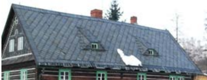
Obr. C-40 Vikýře s šikmými boky v břidlicové střeše (Kryštofovo Údolí), vikýře typu volských ok v krytině z pálených tašek (Starý Týn)
