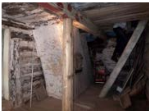
Obr. D-4 a Obr. D-5 Omítnutý dymník v horním patře a v podkroví, Ličenice, 2008
