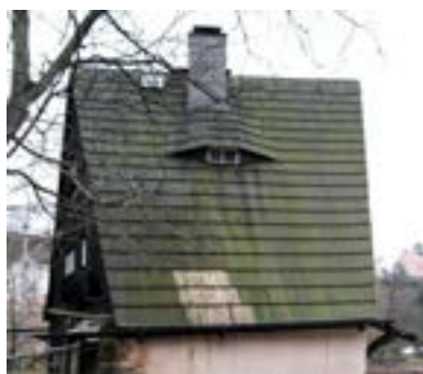
Obr. C-6 Silně poškozená střecha z dřevěných šindelů
