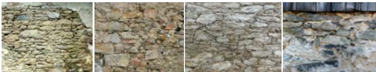
Obr. B-23 Přírodní kamenné zdivo z valounů nebo lomového kamene (žula, pískovec, droba a znělec), původně omítnuté
