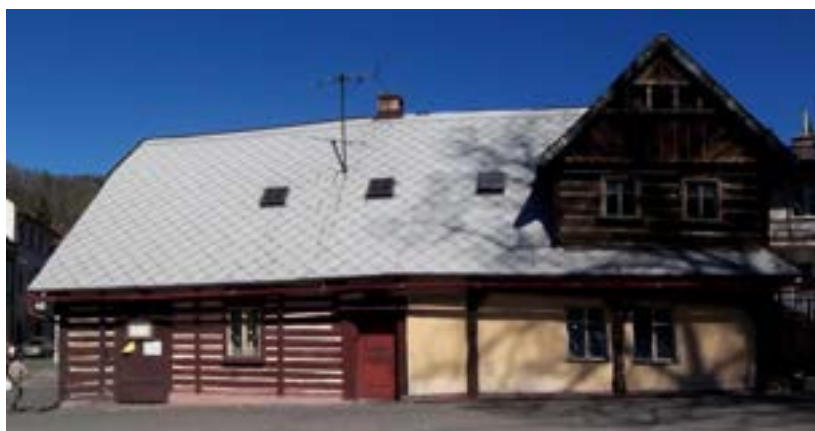
Obr. C-26 Nové vláknocementové krytiny v barvě břidlice: vlevo a uprostřed z šablon, vpravo zvlněné tašky (netradiční a nevhodný formát a tvar)
