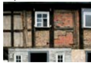
Obr. B-107 Vyzdívký z cihel v hrázdění
