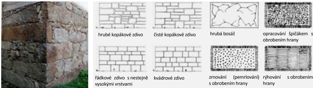
Obr. B-24 Vazba nároží žulového zdiva
