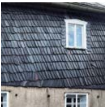
Obr. C-86 Vlevo: Staroněmecký obklad ve Weifa/ Uprostřed a vpravo: Pravoúhlé šablony v Neukirchu/L. a ve Vlčí hoře
