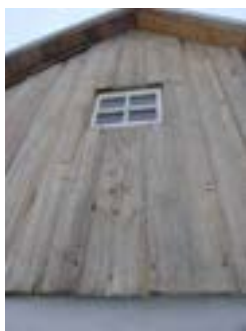
Obr. C-66 Překládaný obklad v patře. (Dolní Řasnice) Foto M. Maršálek
