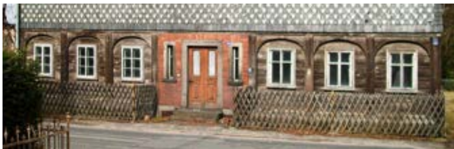
Obr. B-36 Zdivo ze zvonivek u síně / (Neugersdorf / Foto: J. Gosteli, výřez) / Obr. B-37 Použití zvonivek ve vstupní části a jako podstávková podezdívka (Rumburk)
