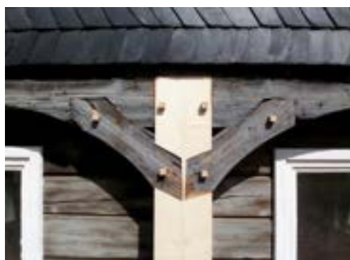
Obr. B-78 Náročně protézovaný středový sloup (Foto: A. Matthes) / Obr. B-79 Nový středový sloup, přizpůsobený stávajícím páskům, zajištěný dřevěnými hřeby / Obr. B-80 Precizně vyčištěné spáry (zbavené třísek)
