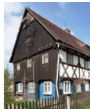
Obr. C-69 Krycí prkno zhlaví přesahujícího trámu roubení a tzv. vánočka na spodní hraně štítu před opravou (Železný Brod) Foto M. Kolka
