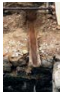
Obr. D-28 Dřevěné odtokové koryto, obec Berthelsdorf (Foto: Nestler)
