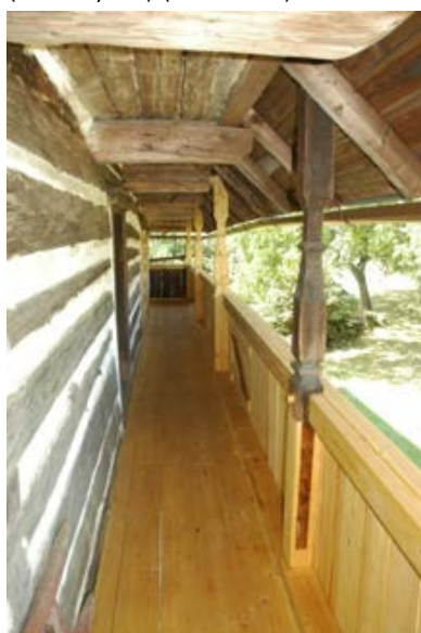
Obr. B-132 (skupina) Průhled pavlačí po obnově: první sloupek vpravo je nastaven plátem; vrchní zdobená část zůstala zachována. (Foto J. Pešta)
