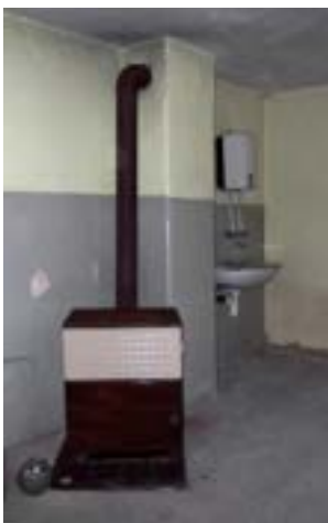
Obr. D-16 Pomalu hořící kamna a elektrický bojler v umývárně
