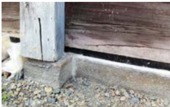
Obr. B-95 Deska z pěnového skla jako dělicí vrstva („Pilgerhäusl“, Hirschfelde)
