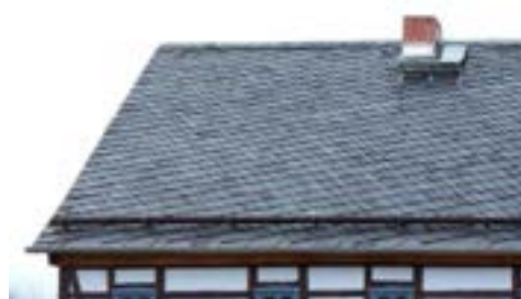
Obr. C-18 Staroněmecká pokládka se stoupajícími řadami a vázanými okraji (nákras z Mittag, M. (1952). Baukonstruktionslehre . Gütersloh: C. Bertelsmann Verlag, upraveno) / staroněmecky pokrytá střecha v Krumhermsdorf (Sächs. Schweiz)
