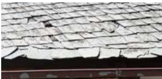
Obr. C-22 Počínající rozpad břidlicové krytiny
