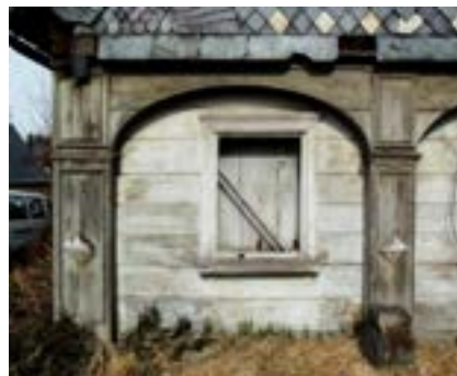
Obr. C-75 Dřevěný obklad roubené světnice a podstávky (Neugersdorf)
