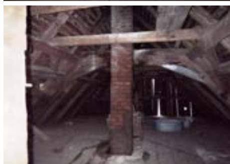
Obr. B-177 (skupina): Krov se střední stolicí s vaznicí podepřenou sloupky / hambálový krov s podélným zavětrováním / vaznicový krov s dvojitou stojatou stolicí, s pásky, příčně ztužený párovými kleštinami / hambálový krov s ležatou stolicí, s rozpěrami a pásky
