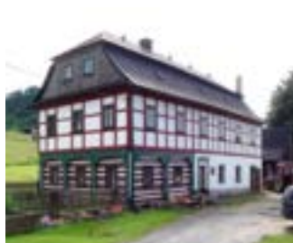
Obr. B-157 Mansardová střecha, obec Schirgiswalde / Obr. B-158 Polovalbová mansardová střecha v obci Vysoká Lípa / Obr. B-159 Valbová mansardová střecha, obec Mikulášovice / Obr. B-160 Valbová střecha, obec Niedercunnersdorf
