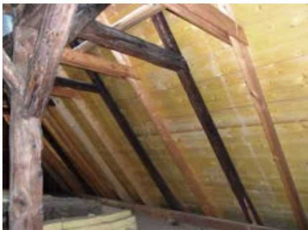
Obr. C-50 Stávající krokve jsou „podporovány“ druhou vrstvou krokvi
