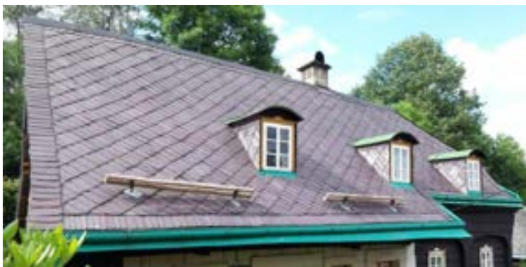
Obr. C-34 Regionálně typické částečné sněhové zábrany ve Vysoké Lípě
