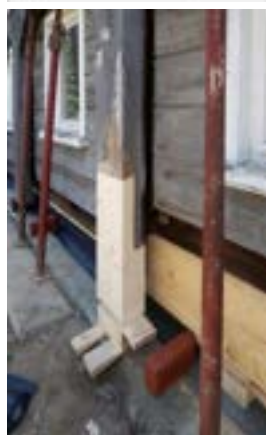
Obr. B-75 Vyprotézovaná pata sloupu při současném obnovení podezdívky z lícových cihel / Obr. B-76 Dubová podložka pod obnovenou patou nárožního sloupu / Obr. B-77 Nové patky sloupů na vyvýšených kamenných deskách obnoveného soklového zdiva z lomového kamene
