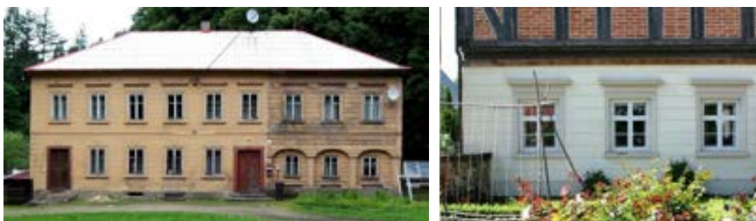
Obr. C-54 Hrubá omítka, kamenné ostění / omítka s lizénovými rámci v Malé Skále, nárožní kvádrová bosáž a členění omítky v Jestřebicích
