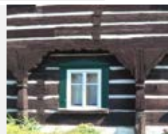
Připojení vnitřních příček
