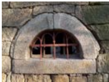
Obr. B-31 Okenní ostění s drážkou pro původní omítku na budově chlěva (stáje).
