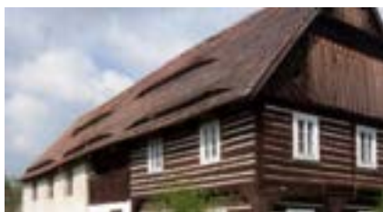
Obr. C-35 Větrací „pásky“ v úrovni podkroví, Lhota (Ústecký kraj), Wartha (Landkreis Bautzen) a Bukovec (okres Česká Lípa/Foto: J. Cieslak, upraveno)
