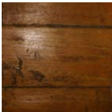
Obr. C-106 „Pivní lazura“: směs odstátého piva a pigmentu / Nátěr olejovou barvou s ozdobným lemem, znečištěný / Obložení dřevěnými kazetami v selském domě
