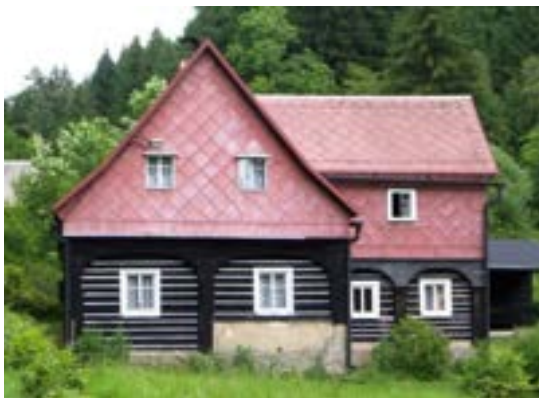
Obr. C-87 Vlevo: Eternitový obklad z maloformátových šablon červeného odstínu (Vlčí hora)/ Vpravo: Obklad z maloformátových šablon
