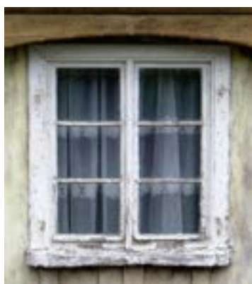
Obr. C-135 Rozhodnutí zde může znít jen: kompletně odstranit všechny vrstvy barev.
