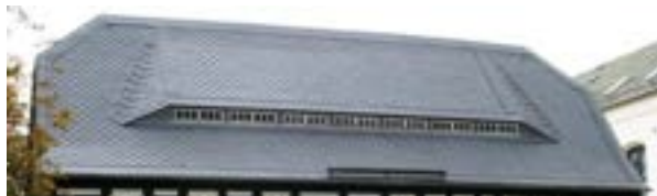
Obr. C-37 „Štika“ v břidlicové krytině (Cunewalde), na okrajích jsou použity lemy
