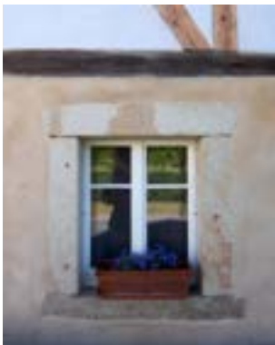
Obr. B-39 Jednoduchá obruba otvoru s deskami z lomového kamene (Kleinkunitz)
