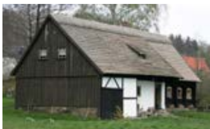
Obr. C-4 Změny původní slaměné střechy včetně vikýře v Schönbach:
