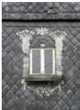
Obr. C-84 Vlevo: Malovaný vzor tvořící orámování okna (Sohland)/ uprostřed a vpravo: srovnání vzoru s umělohmotnými deskami (Wehrsdorf) a z přírodní břidlice (Sebnitz)
