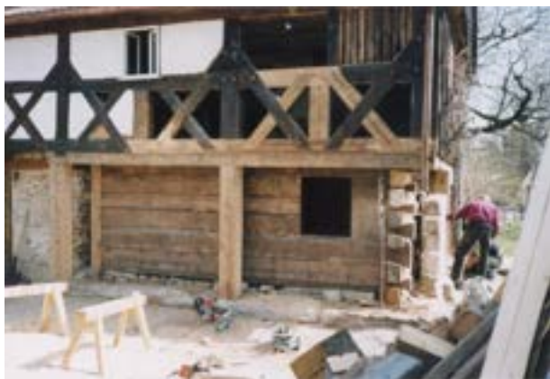
Obr. C-64 Roubená světnice ve Waditz nově opravená starým dřevem (Foto: Fa. Klippel) / Následné obnovení omítky světnice (Foto: A. Matthes)
