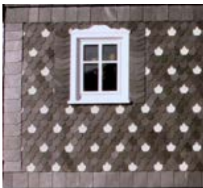
Obr. C-85 Obklady plástvovými šablonami doplněné bílými plástvovými šablonami / Uprostřed: Kříž, srdce a kotvy na plástvovém obkladu / Vpravo: Obklad šupinovou šablonou (kresba: BWB rukopis nového vydání, Vojtíšek)
