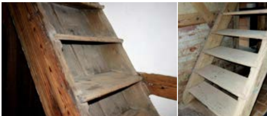
Obr. C-166 Jednoduché schodnicové schodiště s nasunutými schody, velmi příkré
