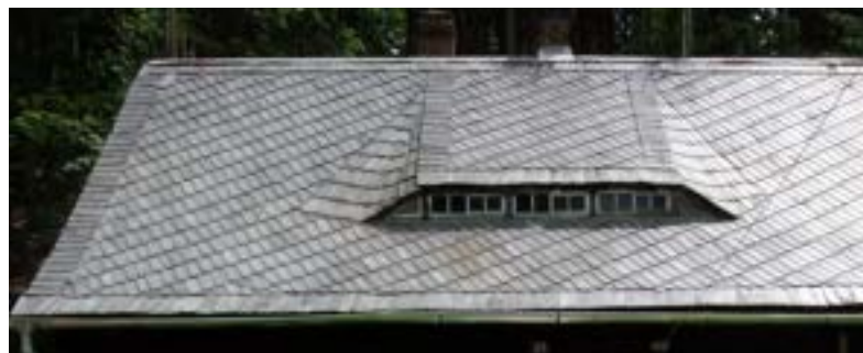
Obr. C-20 Německé jednoduché krytí se stoupajícími řadami a okrajovým lemem
