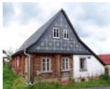
Obr. B-36 Zdivo ze zvonivek u síně / (Neugersdorf / Foto: J. Gosteli, výřez) / Obr. B-37 Použití zvonivek ve vstupní části a jako podstávková podezdívka (Rumburk)
