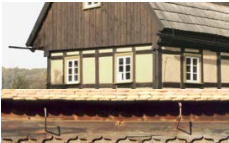
Obr. C-32 Dřevěné okapy (Bertsdorf) / okapové háky upevněné ve zdi (nově vyrobené, Ebersbach)
