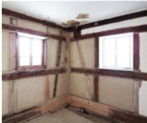
Obr. B-110 Odborná oprava ližiny podstávky, prahu hrázdění a patek sloupů hrázdění (Halbendorf)
