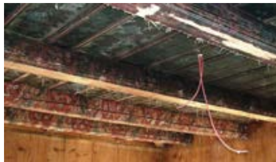
Obr. B-146 Bohatě utvářený stropní trám (Faktorský dvůr Eibau) / Obr. B-147 Diagonálně položený zapuštěný záklop (Vilémov) / Obr. B-148 Dřevěný bohatě pomalovaný trámový strop, uvolněný při rekonstrukčních pracích v horním patře, polovina 18. stol. (Seifhennersdorf, Faktorský dvůr Bulnheim)
