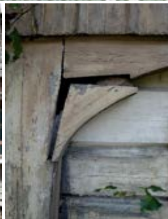
Obr. B-70 (vlevo): Pata sloupu zničená vlhkostí a dřevokaznými škůdci/ Obr. B-71 (vpravo): Stopy degradace dřeva a staré napadení dřevěné srubové konstrukce
