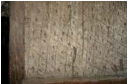
Obr. C-112: Vlevo: „1781“: Vzhůru nohama (?) umístěná datace stavby, při prezentaci přiloženo jako foto / Uprostřed a vpravo: Vzory hřebene nebo prstů v hliněné mazanině, natřené vápnem
