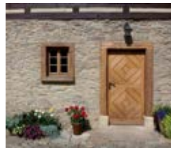
Obr. B-32 Viditelnost kamenů zdiva z valounů / Obr. B-33 Zdivo z pískovce, chráněno širokým přesahem střešky (lze tušit dřívější omítku na základě vystupujícího ostění) / Obr. B-34 Nová viditelnost kamenů zdiva z malých kusů přírodních kamenů po sanaci
