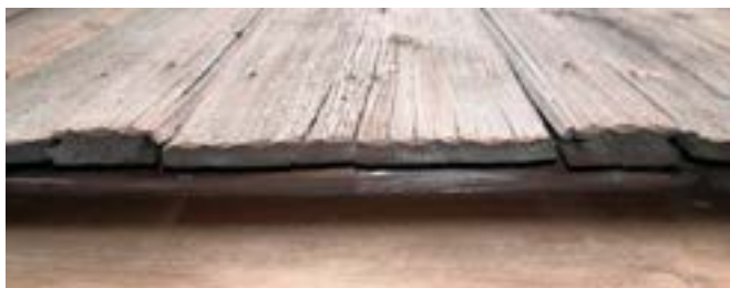
Obr. C-77 Obklad podkrovního polopatra s iluzivní pásovou bosáží a diamantováním (Großschönau)
