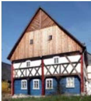
Obr. A-6 Hrázďená stavba s jednoduchou konstrukcí podstavky a patra, tedy s dlouhými sloupky - štenyři (Oberseifersdorf)
