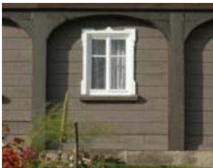
Obr. C-74 Bednění roubené světnice imitující pásovou bosáž omítaných fasád (Bertsdorf)
