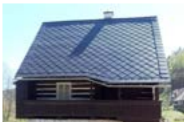
Obr. C-26 Nové vláknocementové krytiny v barvě břidlice: vlevo a uprostřed z šablon, vpravo zvlněné tašky (netradiční a nevhodný formát a tvar)
