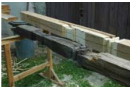
Obr. B-131 Výroba nových sloupků podle originálních (zachovaly se 3). (Foto J. Pešta)
