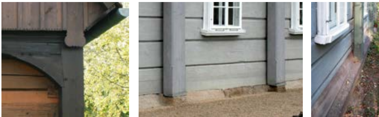
Obr. B-181 Profilovaná prkna a řezba na dolní straně bednění / provedení pískovcového soklu odvádějícího vodu / sloup na podezdívce
