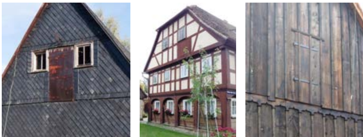
Obr. C-156 Vyobrazení zleva doprava: oplechovaný otvor před rekonstrukcí v Ebersbach / Otvor ve štítovém průčelí s prezentovaným hrázdním, barevně sladěno se dřevem, Großschönau / Nenápadně integrovaný otvor v Ebersbach
