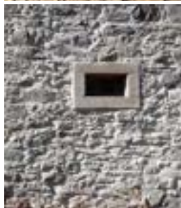
Obr. B-32 Viditelnost kamenů zdiva z valounů / Obr. B-33 Zdivo z pískovce, chráněno širokým přesahem střešky (lze tušit dřívější omítku na základě vystupujícího ostění) / Obr. B-34 Nová viditelnost kamenů zdiva z malých kusů přírodních kamenů po sanaci
