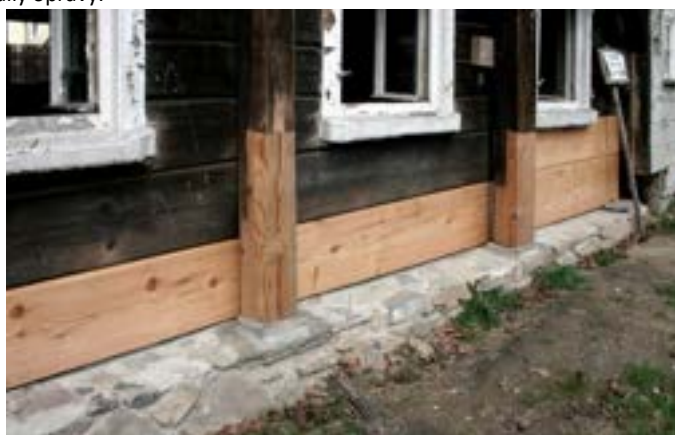
Obr. B-75 Vyprotézovaná pata sloupu při současném obnovení podezdívky z lícových cihel / Obr. B-76 Dubová podložka pod obnovenou patou nárožního sloupu / Obr. B-77 Nové patky sloupů na vyvýšených kamenných deskách obnoveného soklového zdiva z lomového kamene
