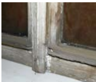
Obr. C-136 Zničená okapnice, prasklá příčka, silně zrezavělé kování s vadami
