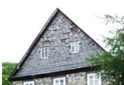
Obr. C-86 Vlevo: Staroněmecký obklad ve Weifa/ Uprostřed a vpravo: Pravoúhlé šablony v Neukirchu/L. a ve Vlčí hoře
