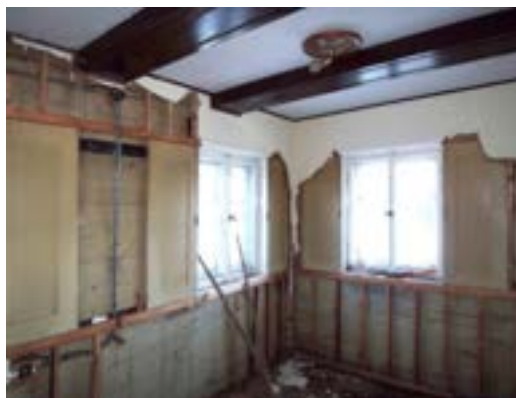
Obr. C-107 Pomalované kazety ve faktorském domě / Odstraňování novodobých obkladů novým majitelem domu: objevují se dokonce posuvné okenice (nářečně „Ritschel“)
