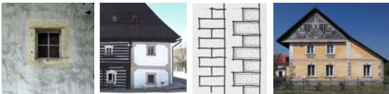
Obr. C-54 Hrubá omítka, kamenné ostění / omítka s lizénovými rámci v Malé Skále, nárožní kvádrová bosáž a členění omítky v Jestřebicích
