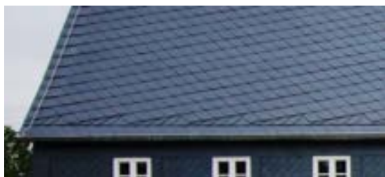
Obr. C-23 Břidlicová pokrývka se šablonami s obloukovým řezem (Rammenau)
