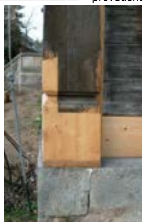
Obr. B-75 Vyprotézovaná pata sloupu při současném obnovení podezdívky z lícových cihel / Obr. B-76 Dubová podložka pod obnovenou patou nárožního sloupu / Obr. B-77 Nové patky sloupů na vyvýšených kamenných deskách obnoveného soklového zdiva z lomového kamene
