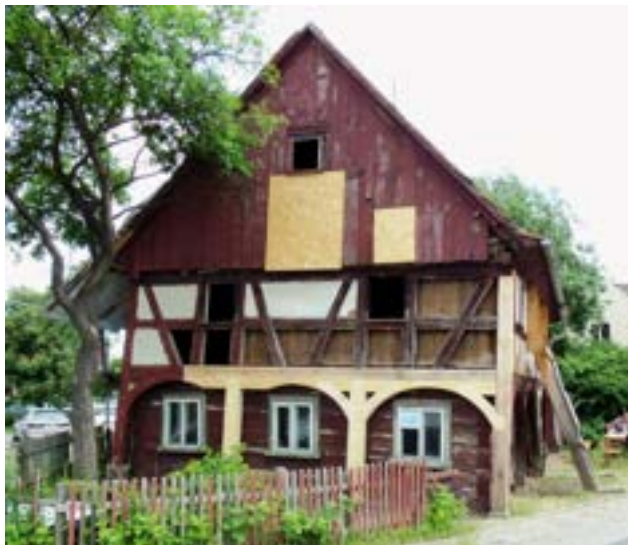
Obr. A-14 Obec Hirschfelde: Opravený dům při současném zachování deformací konstrukce.
