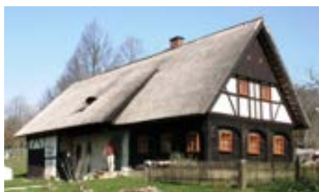
Obr. B-53 Hrázděná stavba s podstavkou konstrukčně nespojenou s patrem (Základ zpracovaného nákresu: Deutschmann, E. (1959). Lužická dřevěná architektura (Lausitzer Holzbaukunst) . Bautzen: VEB Domowina nakladatelství, tab. 17, str. 179, nákres prof. E. Deutschmann)
