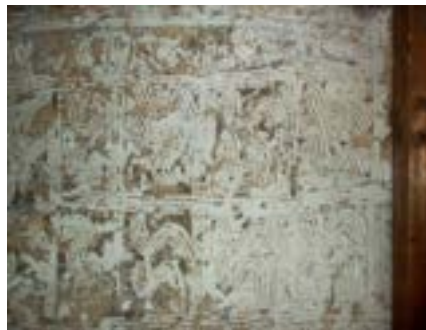
Obr. C-112: Vlevo: „1781“: Vzhůru nohama (?) umístěná datace stavby, při prezentaci přiloženo jako foto / Uprostřed a vpravo: Vzory hřebene nebo prstů v hliněné mazanině, natřené vápnem
