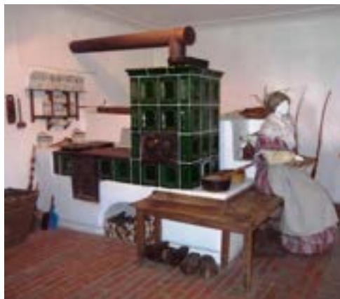
Obr. D-13 Kamna s hranatým rourovým kouřovodem a (od shora dolů) výměníkem, nádobou na vodu, troubou na pečení, dvířky topeniště a popelníku.
