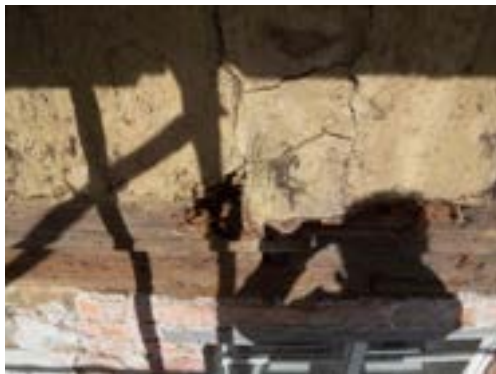
Obr. C-79 Prohlídka odkryté hrázděné fasády
