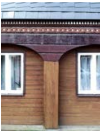
Obr. C-81 Vlevo: Zbytky bedněné konstrukce s profrézovaným zubořezem, malými diamantovými kvádry, pletencem s květy u nevhodně opraveného obložení podstavky a světnice / Uprostřed: Z domu se stala bedna. / Vpravo: Neživé nové bednění
