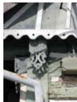
Obr. C-69 Krycí prkno zhlaví přesahujícího trámu roubení a tzv. vánočka na spodní hraně štítu před opravou (Železný Brod) Foto M. Kolka
