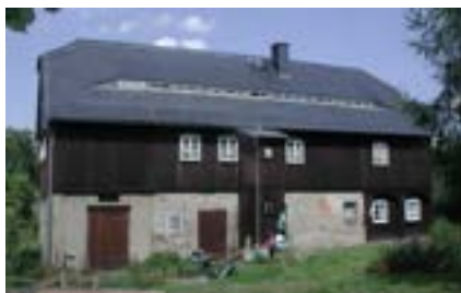
Obr. D-30 Přístavba záchodu v obci Cunewalde
