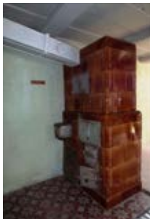
Obr. D-13 Kamna s hranatým rourovým kouřovodem a (od shora dolů) výměníkem, nádobou na vodu, troubou na pečení, dvířky topeniště a popelníku.
