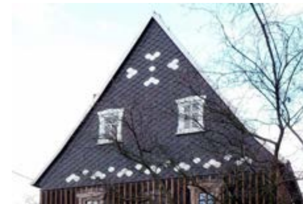
Obr. C-93 Srovnání mezi regionálně typickým tradičním břidlicovým obkladem a mladším štítovým obkladem
