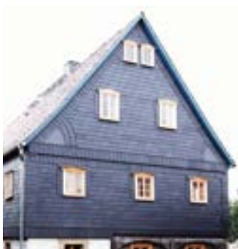
Obr. C-86 Vlevo: Staroněmecký obklad ve Weifa/ Uprostřed a vpravo: Pravoúhlé šablony v Neukirchu/L. a ve Vlčí hoře
