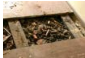
Obr. B-145 Zapuštěný záklop – plnění ze suché směsi jílu, sena a strusky
