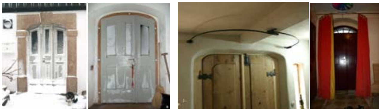
Obr. C-153 Zatížení vnějších dveří / Závěs „portiera“ jako jednoduché a účinné protiopatření
