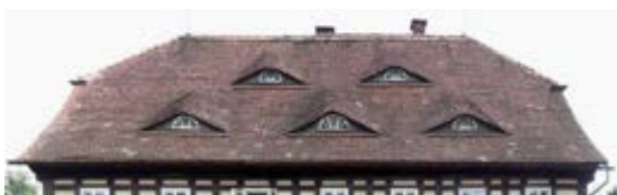
Obr. C-41 Další varianty „volského oka“ (název odvozen od polokruhových oken), v krytině z pálených tašek (Großschönau) / a v břidlicové krytině (Železný Brod)
