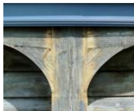
Obr. B-78 Náročně protézovaný středový sloup (Foto: A. Matthes) / Obr. B-79 Nový středový sloup, přizpůsobený stávajícím páskům, zajištěný dřevěnými hřeby / Obr. B-80 Precizně vyčištěné spáry (zbavené třísek)
