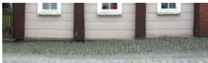
Obr. B-16 Klesající podezdívka
