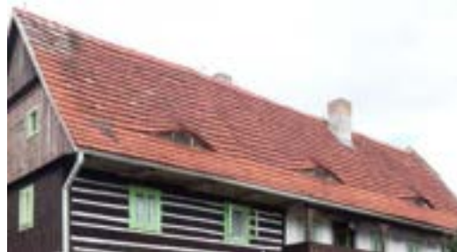
Obr. C-40 Vikýře s šikmými boky v břidlicové střeše (Kryštofovo Údolí), vikýře typu volských ok v krytině z pálených tašek (Starý Týn)
