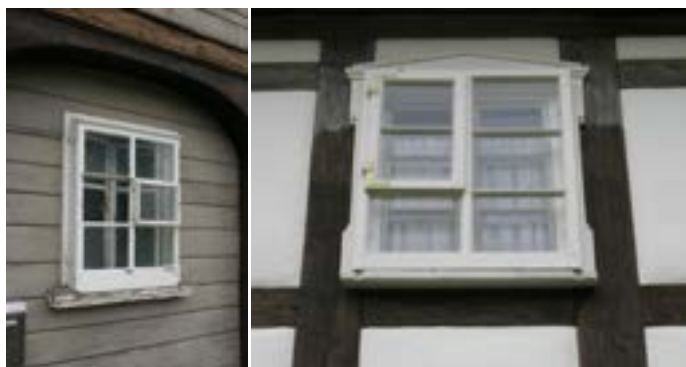
Obr. C-131 Zimní okna na roubené světnici a v patře
