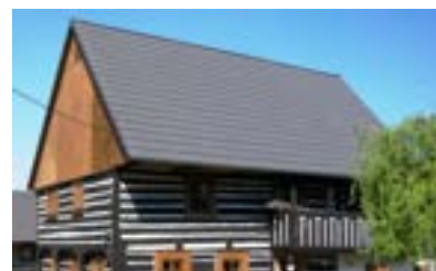
Obr. C-26 Nové vláknocementové krytiny v barvě břidlice: vlevo a uprostřed z šablon, vpravo zvlněné tašky (netradiční a nevhodný formát a tvar)
