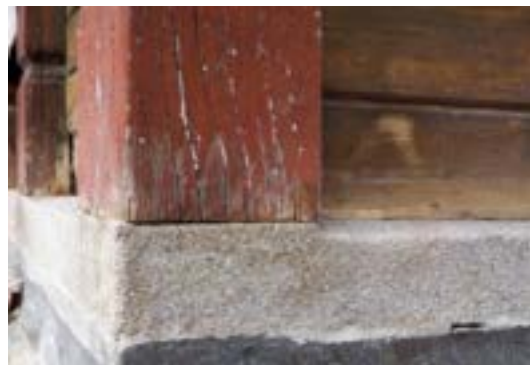
Obr. B-10 Ideální řešení soklového kamene, Friedersdorf
