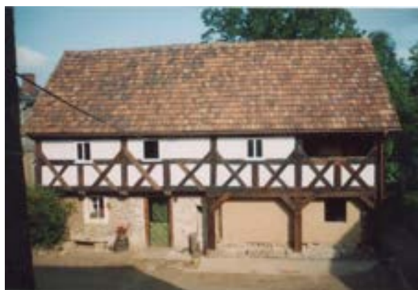
Obr. C-64 Roubená světnice ve Waditz nově opravená starým dřevem (Foto: Fa. Klippel) / Následné obnovení omítky světnice (Foto: A. Matthes)
