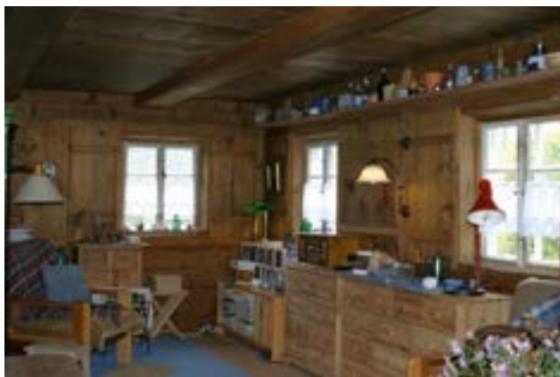
Obr. C-109 Obnovená pohledová uplatnění dřeva na stěnách a stropě a obnova světlého nátěru
