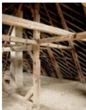
Obr. B-178 Středový sloup s četnými chybějícími prvky a Obr. B-179 Opravený styčník po doplnění
