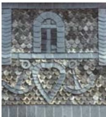
Obr. C-85 Obklady plástvovými šablonami doplněné bílými plástvovými šablonami / Uprostřed: Kříž, srdce a kotvy na plástvovém obkladu / Vpravo: Obklad šupinovou šablonou (kresba: BWB rukopis nového vydání, Vojtíšek)
