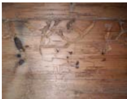
Obr. C-108 Vyžrané cestičky škůdců dřeva
