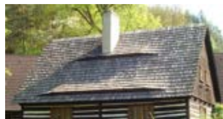
Obr. C-35 Větrací „pásky“ v úrovni podkroví, Lhota (Ústecký kraj), Wartha (Landkreis Bautzen) a Bukovec (okres Česká Lípa/Foto: J. Cieslak, upraveno)
