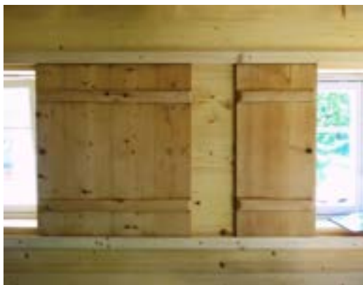
Obr. C-141 Opravené vnitřní zasunovací okenice v roubené světnici, účinná ochrana tepla a ochrana před kondenzací vody za chladných nocí a v chladných ročních obdobích
