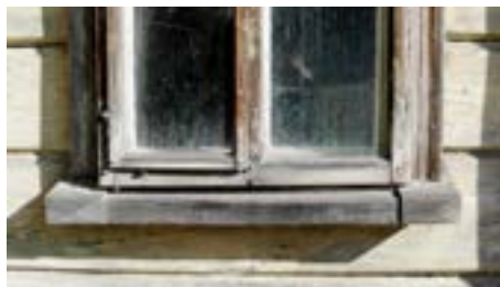
Obr. C-136 Zničená okapnice, prasklá příčka, silně zrezavělé kování s vadami
