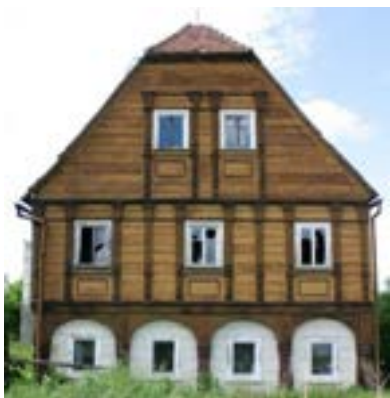
Obr. C-76 Obklad patra, sloupky podstávky nejsou zakryty: vlevo: Eibau/ uprostřed: Oderwitz/ vpravo: Leutersdorf
