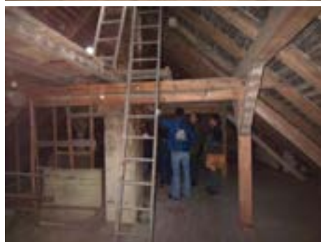
Obr. B-174 Náčrt krovu s vaznicí pod hambálky, podepřený sloupky, obec Crostwitz
