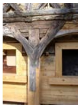
Obr. B-78 Náročně protézovaný středový sloup (Foto: A. Matthes) / Obr. B-79 Nový středový sloup, přizpůsobený stávajícím páskům, zajištěný dřevěnými hřeby / Obr. B-80 Precizně vyčištěné spáry (zbavené třísek)
