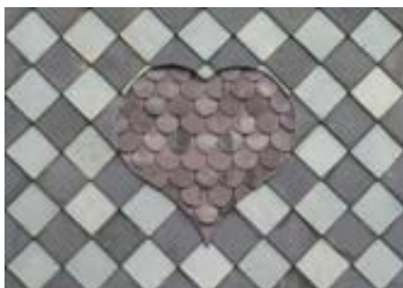
Obr. C-83 Obklady byly často zesvětlované „bílou“ přírodní břidlicí, srdce je z fialových šupinových šablon (Berthelsdorf)
