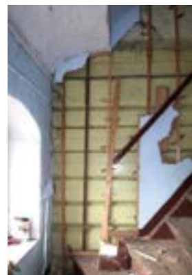
Obr. C-107 Pomalované kazety ve faktorském domě / Odstraňování novodobých obkladů novým majitelem domu: objevují se dokonce posuvné okenice (nářečně „Ritschel“)
