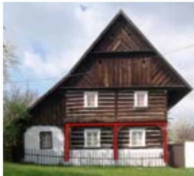
Obr. A-8 Stavba s podstavkou konstrukčně nespojenou s patrem, ale horní patro je roubené (Lhota u Úštěku)
