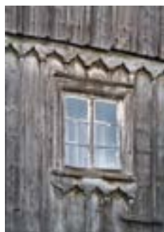
Obr. C-68 Obloučkový vlys prolamovaného tvaru se špičkou, obdobný byl použit pod okny (Obercunnersdorf)
