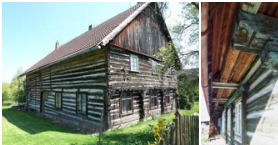
Obr. B-61 Štítová vazba v Jestřebicích / Obr. B-62 Opěrná konstrukce na okapové straně (okapová vazba) v Hrubé Hore
