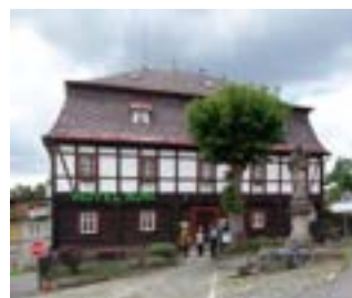
Obr. B-157 Mansardová střecha, obec Schirgiswalde / Obr. B-158 Polovalbová mansardová střecha v obci Vysoká Lípa / Obr. B-159 Valbová mansardová střecha, obec Mikulášovice / Obr. B-160 Valbová střecha, obec Niedercunnersdorf
