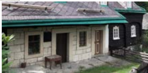
Obr. B-32 Viditelnost kamenů zdiva z valounů / Obr. B-33 Zdivo z pískovce, chráněno širokým přesahem střešky (lze tušit dřívější omítku na základě vystupujícího ostění) / Obr. B-34 Nová viditelnost kamenů zdiva z malých kusů přírodních kamenů po sanaci
