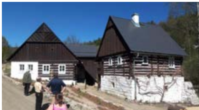
Obr. E-7 Roubená stavba, obytný dům a sýpka se začleněným chlévem,
