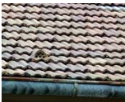
Obr. C-12 Malý rozměr bobrovek umožnil i zapracování takovýchto okrasných prvků.
