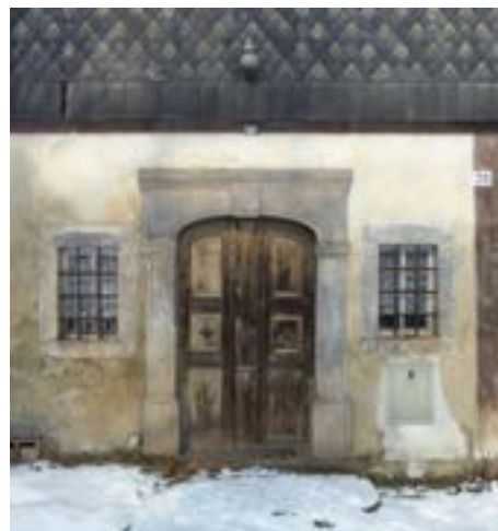
Obr. D-38 Nevhodné umístění elektrické skříně
