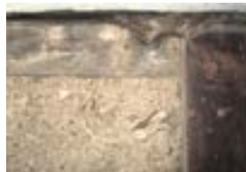
Obr. B-145 Zapuštěný záklop – plnění ze suché směsi jílu, sena a strusky
